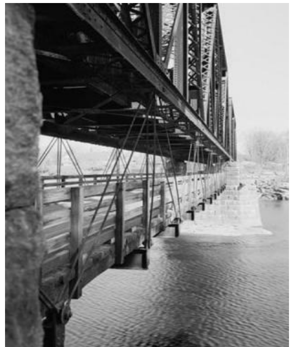
Το κάτω κατάστρωμα Οδογέφυρας της, Γέφυρα Free-Black, ανητημένο σε βλυτρωμένες Ράβδους Εφελκυσμού
