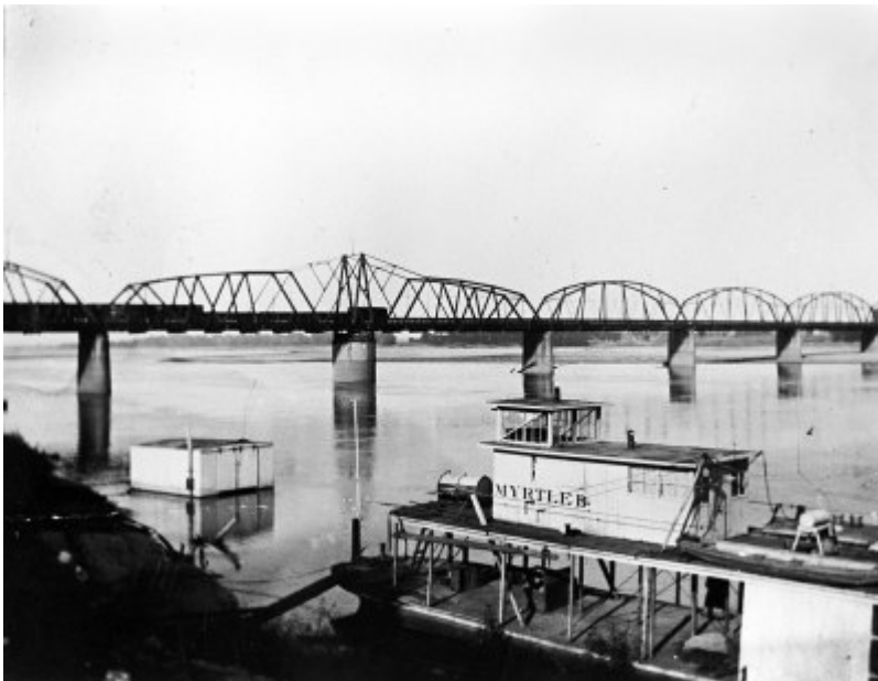
Φωτογραφία από την κατασκευή της Γέφυρας του Arkansas River
