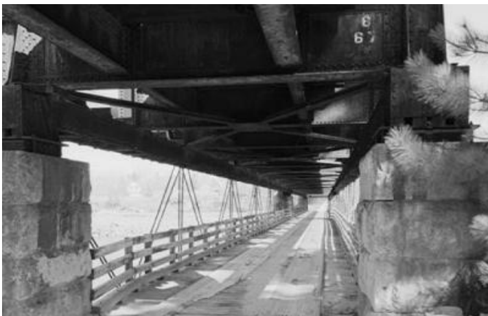
Το κάτω κατάστρωμα Οδογέφυρας της, Γέφυρα Free-Black, ανητημένο σε βλυτρωμένες Ράβδους Εφελκυσμού
