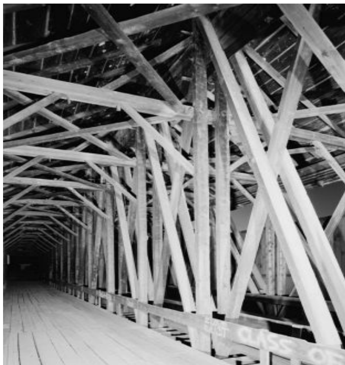
Εσωτερικό Σκεπαστής Γέφυρας τύπου Long
