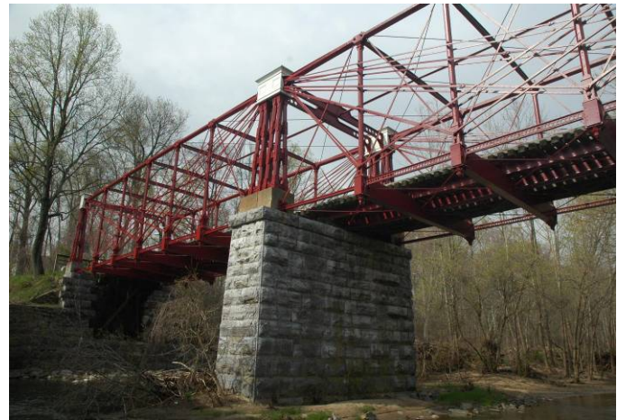
Η μοναδική σωζόμενη Δικτυωτή Γέφυρα τύπου Bollman
