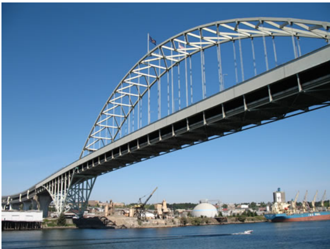
Γέφυρα του Fremont
