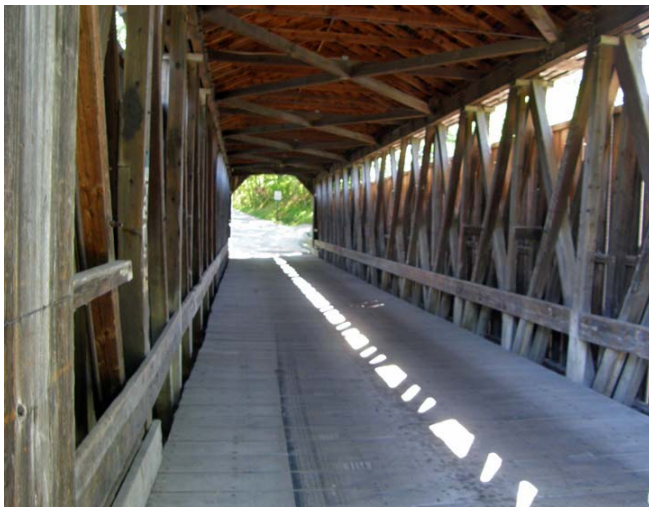
Το Δικτύωμα τύπου Brown στις Γέφυρες Fallasburg και White
