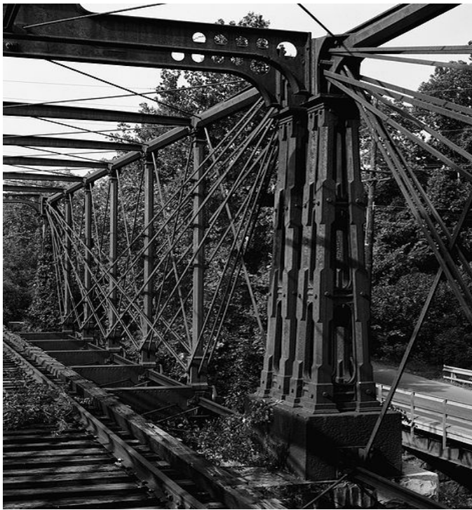
Η μοναδική σωζόμενη Δικτυωτή Γέφυρα τύπου Bollman
