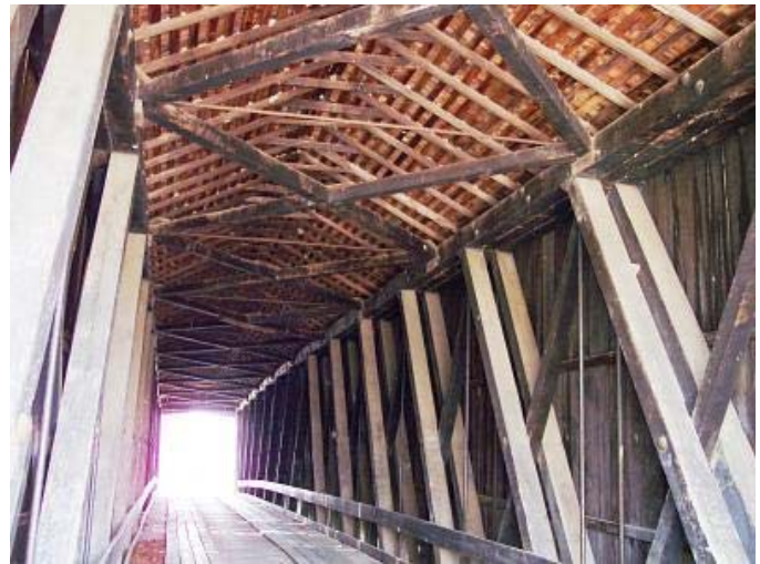
Δικτύωμα και Σκεπή της Γέφυρας Burfordville
