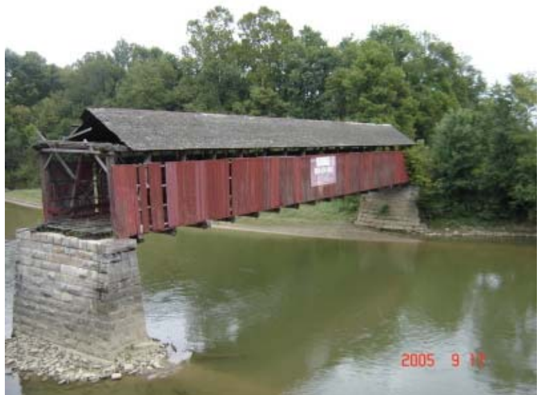
Γέφυρα του Bell Ford
