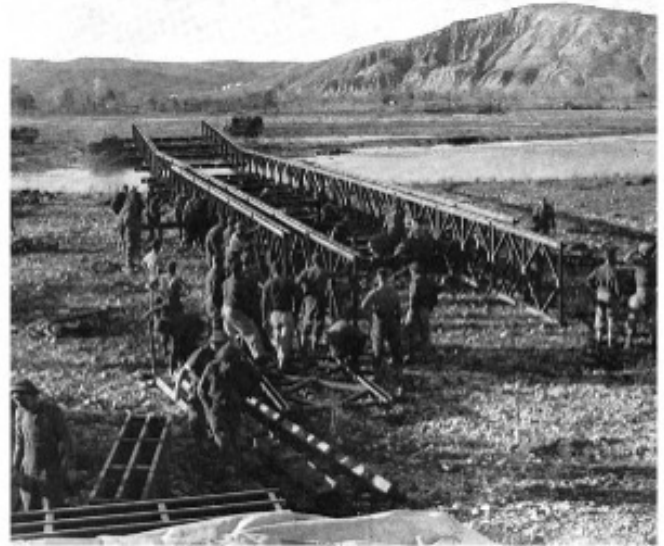
Γέφυρα Bailey στον ποταμό Sangro
