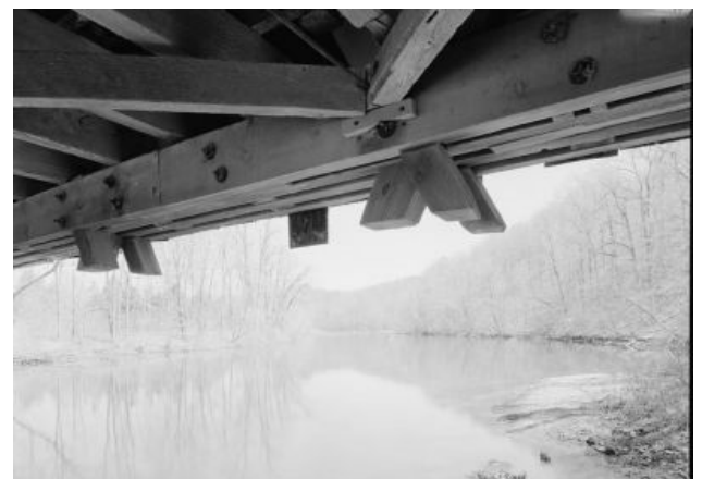
Κόμβος Δικτύωματος Γέφυρας White
