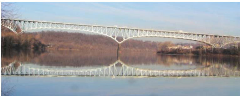
Η Δικτυωτή Γέφυρα τύπου Wichert, Homestead High Level Bridge
