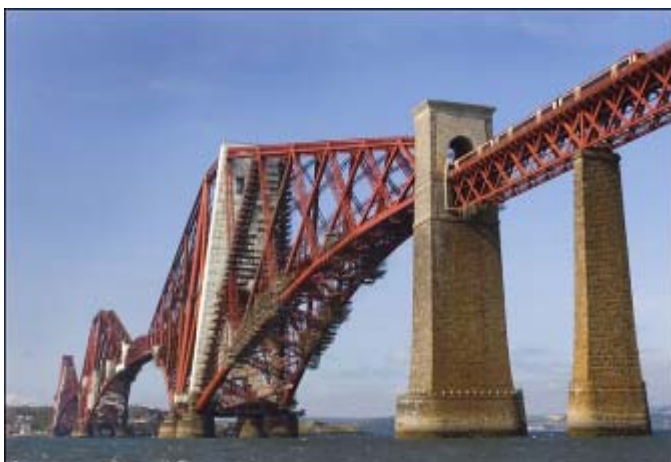
Γέφυρα του Forth
