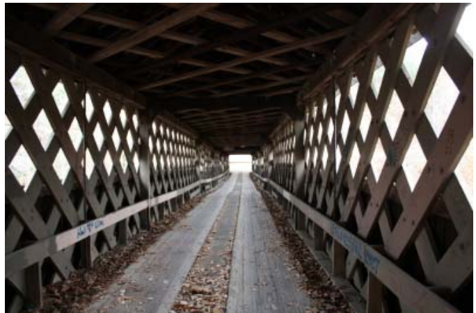
Γέφυρα του Horton Mill
