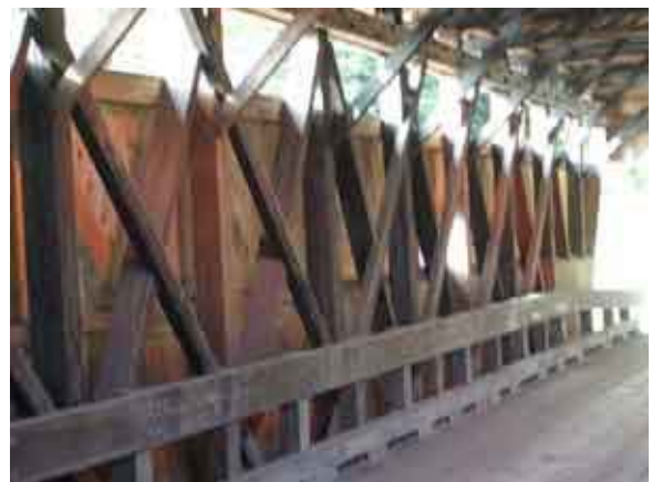
Η Γέφυρα Swiftwater, Δικτυωτή Σκεπαστή τύπου Paddleford, στο Bath
