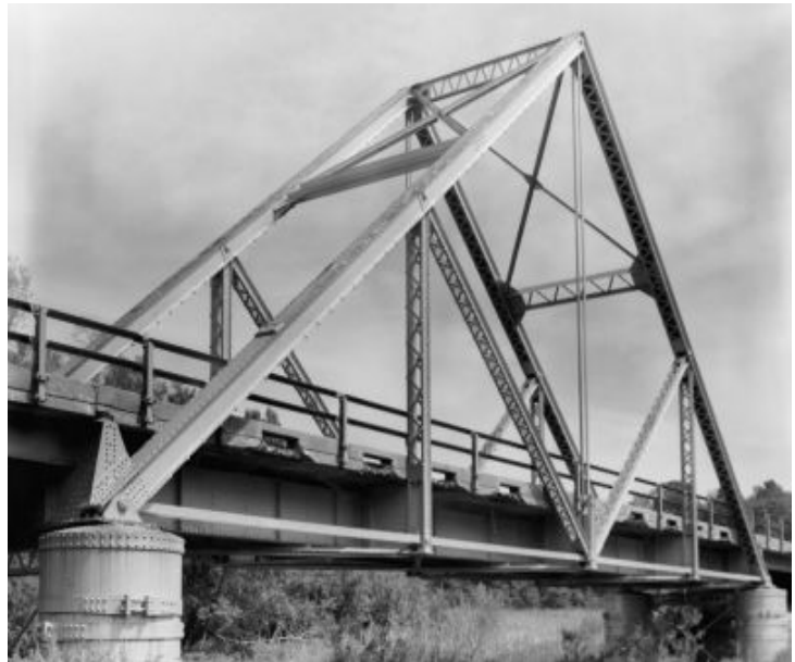
Δικτυωτή Γέφυρα Waddell ‘A’
