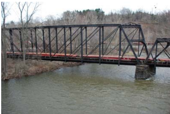
Δικτυωτή Γέφυρα τύπου Whipple
