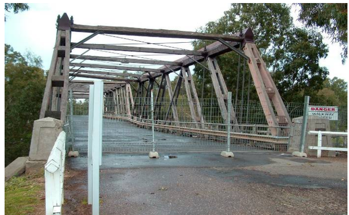
Γέφυρα του Hamden
