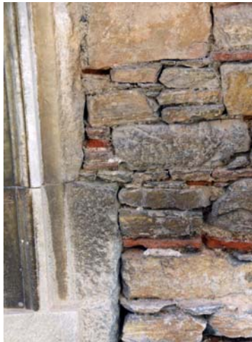
Εικόνα 2/4 Διακρίνουμε την ανισόδομη τοιχοποιία
