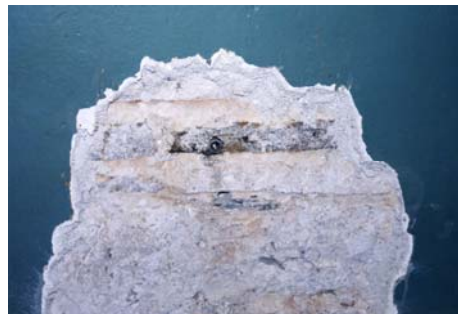
Εικόνα Ι/120 Η τοιχοποιία εσωτερικά του κτιρίου.
