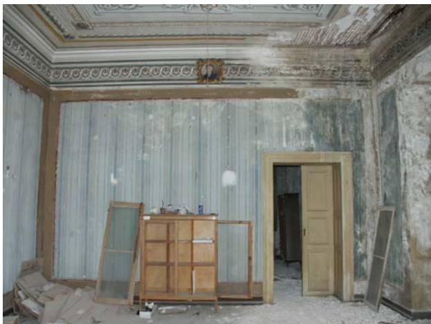
Εικόνα Ι/74 Άποψη του τοίχου ΓΔ
