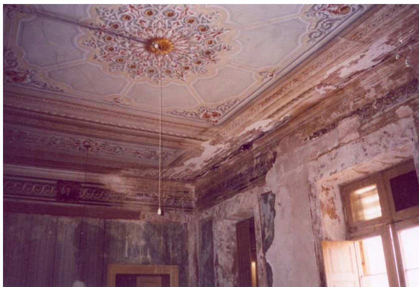
Εικόνα 6/11 Όψη της πλευράς με την παρουσία αλάτων δίπλα στο παράθυρο. Δωμάτιο 2. Επίσης διακρίνονται και οι φθορές στο χρωματικό στρώμα.
