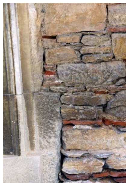
Εικόνα Ι/118 Η τοιχοποιία όπως την βλέπουμε εξωτερικά του κτιρίου
