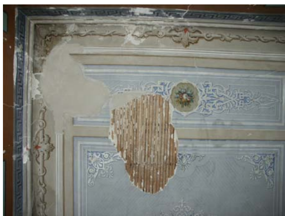
Εικόνα 7/6 Για παράδειγμα αυτή θεωρείται μια αρκετά μεγάλη απώλεια. (δωμάτιο 1, ισόγειο.)
