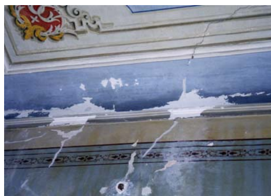
Εικόνα 6/31 Στοκαρίσματα σε ρωγμές και μικρές απώλειες.
