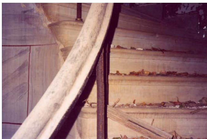
Εικόνα I/53 Άποψη της σκάλας που οδηγεί στον πρώτο όροφο. Διακρίνουμε στα σκαλοπάτια κομμάτια από σοβά.
