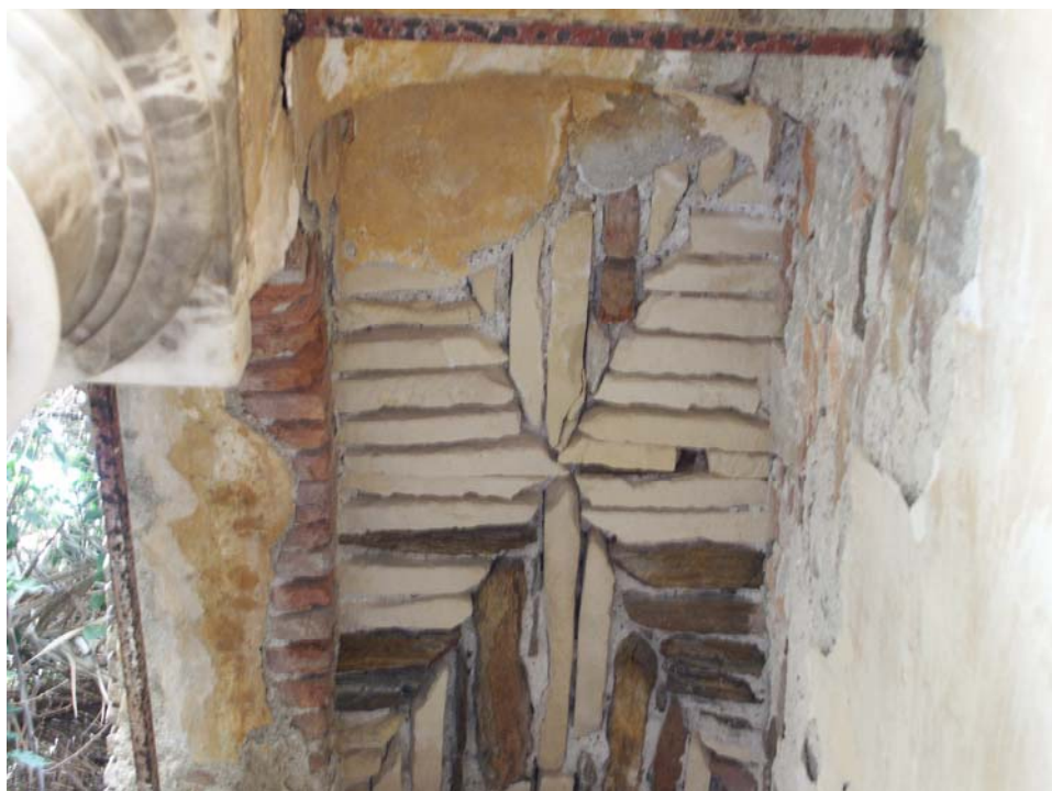
Εικόνα Ι/61 Η οροφή του χώρου 16. Παρατηρούμε πόσο περίτεχνα είναι τοποθετημένες οι πέτρες του υποστηρίγματος.
