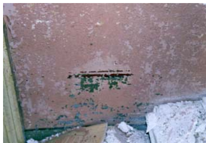
Εικόνα 7/2 Μηχανική αφαίρεση επίθετου πλακάτου πλαστικού χρώματος, στο ύψος του πασαμέντο
