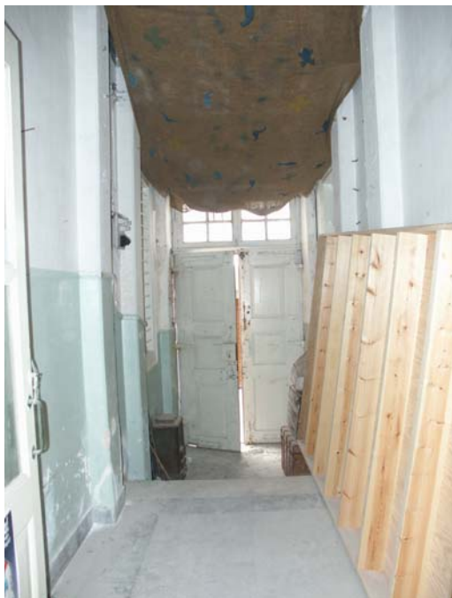
Εικόνα Ι/29 Άποψη από το εσωτερικό προς την μεριά της κεντρική πόρτας του μεγάρου. Τοίχος ΔΑ
