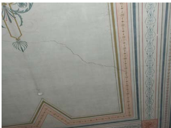
Εικόνα 6/26 Ρωγμή στην οροφografia του δωματίου 4 του ισογείου
