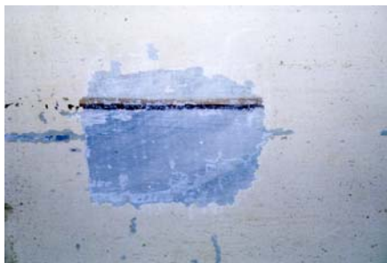
Εικόνα 7/1 Μηχανική αφαίρεση επίθετου πλακάτου πλαστικού χρώματος, στο ύψος του πασαμέντο
