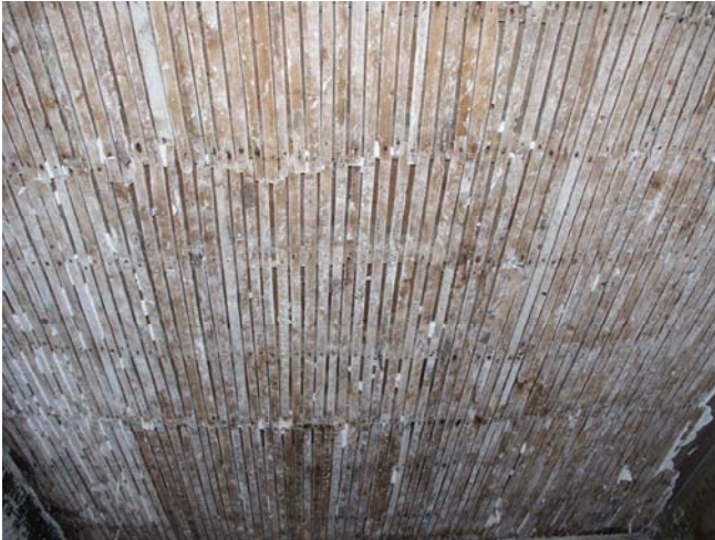
Εικόνα Ι/37 Η οροφή του δωματίου έχει καταπέσει ολοκληρωτικά.
