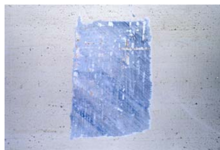
Εικόνα 7/4 Μηχανική αφαίρεση επίθετου πλαστικού χρώματος. Διαφαίνεται ότι το υποκείμενο στρώμα απεικονίζει απομίμηση μαρμάρου
