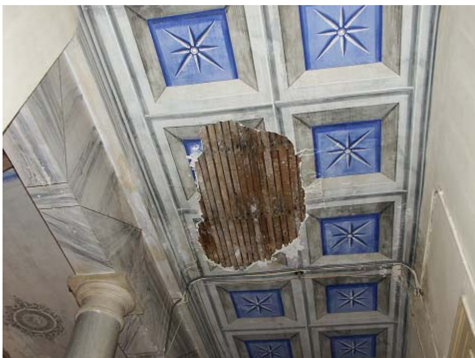
Εικόνα Ι/90 Λεπτομέρεια της απώλειας ζωγραφικής επιφανείας και υποστρώματος. Βλέπουμε το μπαγδατί.
