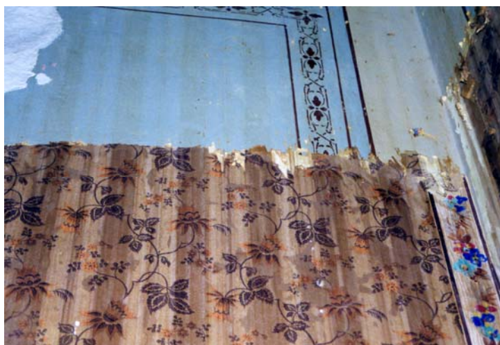
Εικόνα Ι/27 Επάλληλα στρώματα ταπετσαρίας που καλύπτουν τους τοίχους του δωματίου
