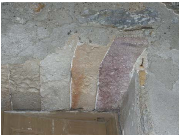
Εικόνα Ι/79 Καθώς το υπόστρωμα έχει καταπέσει, μπορούμε εδώ να παρατηρήσουμε την προσεγγμένη τοιχοποιία, που αποτελεί το υποστήριγμα των τοιχογραφιών.
