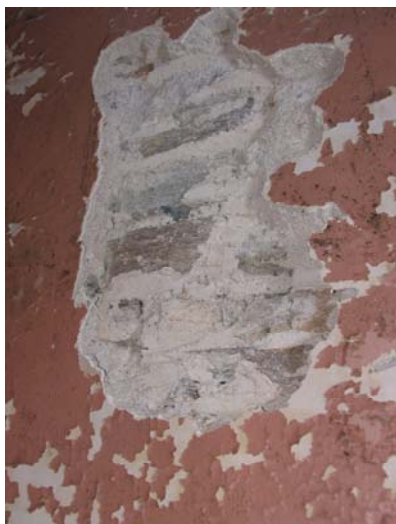
Εικόνα Ι/119 Εσωτερικά και λόγω φθορών ζωγραφικής επιφάνειας και υποστρώματος, έχουμε την δυνατότητα να διακρίνουμε το υποστήριγμα των τοιχογραφιών
