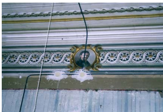
Εικόνα 6/30 Νεότερες επεμβάσεις για την εγκατάσταση ηλεκτρικού ρεύματος στο δωμάτιο 2 του
