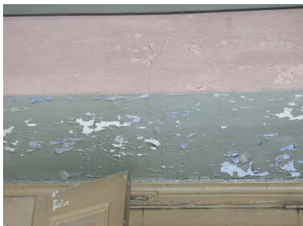
Εικόνα Ι/102 Απφλοιώση του επίθετου πλαστικού χρώματος.
