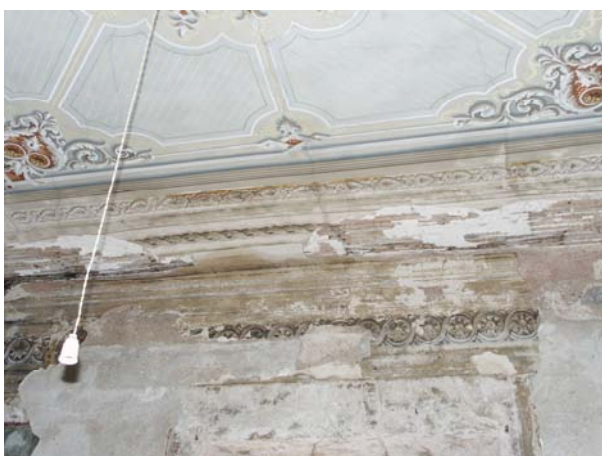
Εικόνα Ι/76 Παρατηρούμε τις απώλειες της χρωματικής επιφάνειας.
