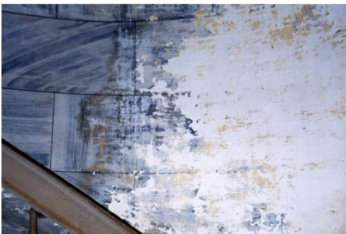
Εικόνα 6/14 Μίμηση μαρμάρου από τον τοίχο της σκάλας . Βλέπουμε την μεγάλη σε έκταση αποφλοιωμένη και αφφλοΐωση λόγω υγρασίας.
