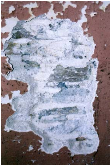
Εικόνα 2/6 Η ζωγραφική και το υπόστρωμα της έχει καταπέσει
