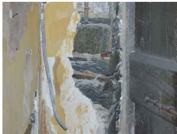
Εικόνα 2/5 Διαφαίνεται η δομή της τοιχοποιίας
