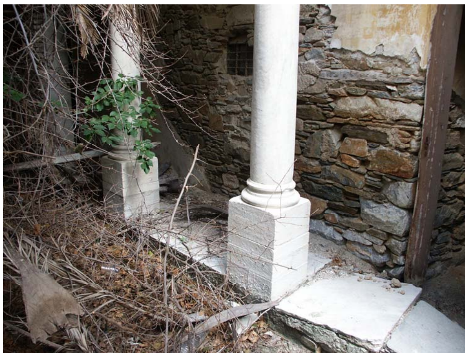
Εικόνα Ι/62 Βλέπουμε την τοιχοδομή.
