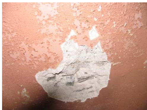
Εικόνα Ι/121 Η τοιχοποιία εσωτερικά του κτιρίου.
