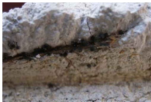
Εικόνα 3/7 Ανάπτυξη μικροοργανισμών
