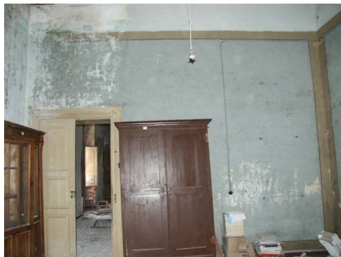
Εικόνα Ι/85 Τοίχος ΔΑ
