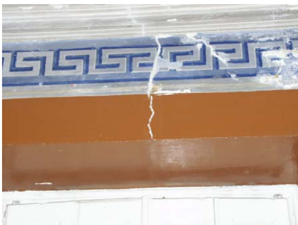
Εικόνα Ι/18 Λεπτομέρεια διακοσμητικού στοιχείου. Μπορούμε να δούμε ρωγμές, που μάλιστα έχουν στοκαριστεί, και το επίθετο πλαστικό χρώμα.
