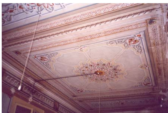
Εικόνα 4/7 Οροφογραφία από το δωμάτιο 2 του ορόφου
