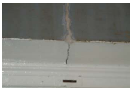
Εικόνα 8/4 Στοκάρισμα επάνω από κάσωμα πόρτας το οποίο δεν δίνει αθόλου καλό αισθητικό αποτέλεσμα.
