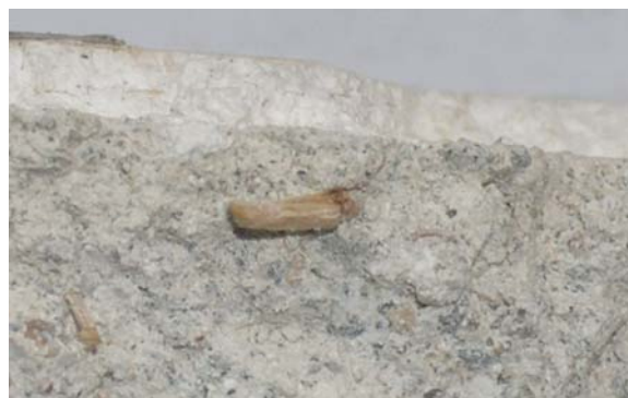
Εικόνα Ι/137 Λεπτομέρεια εικόνας 135. Διακρίνουμε καλύτερα την κοκκομετρία και το άχυρο που είναι αναμεμιγμένο στο κονίαμα.
