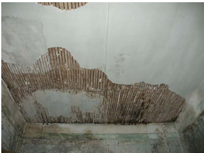
Εικόνα Ι/82 Εξαιτίας της υγρασίας(πιθανολογείτε να είναι υγρασία υγροποίησης) έχει καταπέσει μεγάλο μέρος της οροφογραφίας, αν και δεν έχουμε ζωγραφική.
