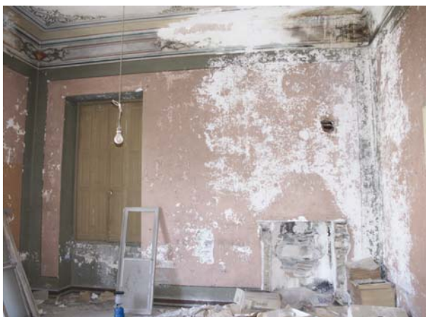
Εικόνα Ι/98 Τοίχος ΕΖ. Επίδραση της εισερχόμενη υγρασίας από την φθαρμένη στέγη.
