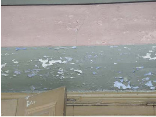
Εικόνα 6/12 Αποφλοιώσεις στο τελευταίο χρωματικό στρώμα (λαδομπογιά)
