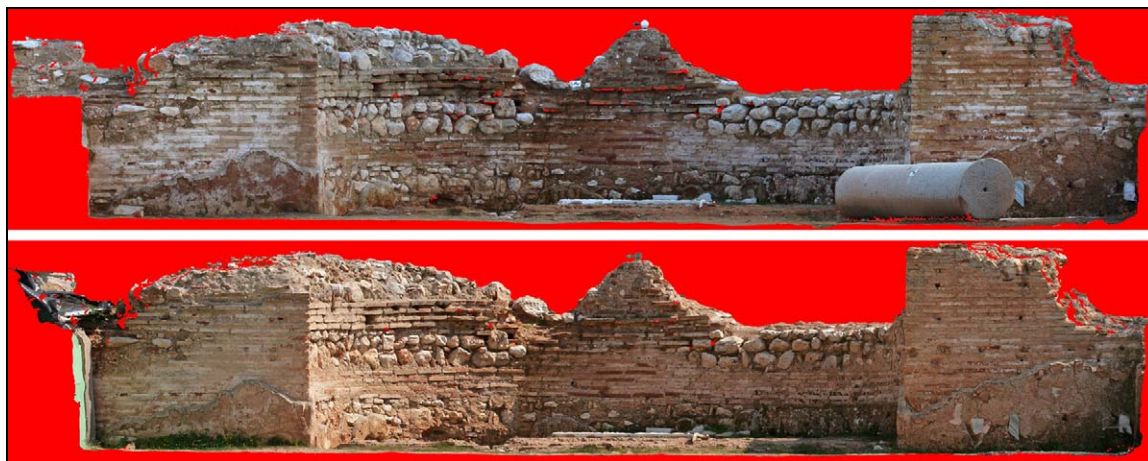
Εικόνα 49. Τελική ορθοφωτογραφία από τα δύο μπλοκ εικόνων του τμήματος 1 του μοντέλου.
