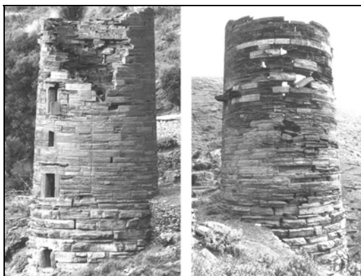
Εικόνα 2. Ο κωνικός πύργος Αγ. Πέτρου. Figure 2. The conic Ag. Petros tower.
