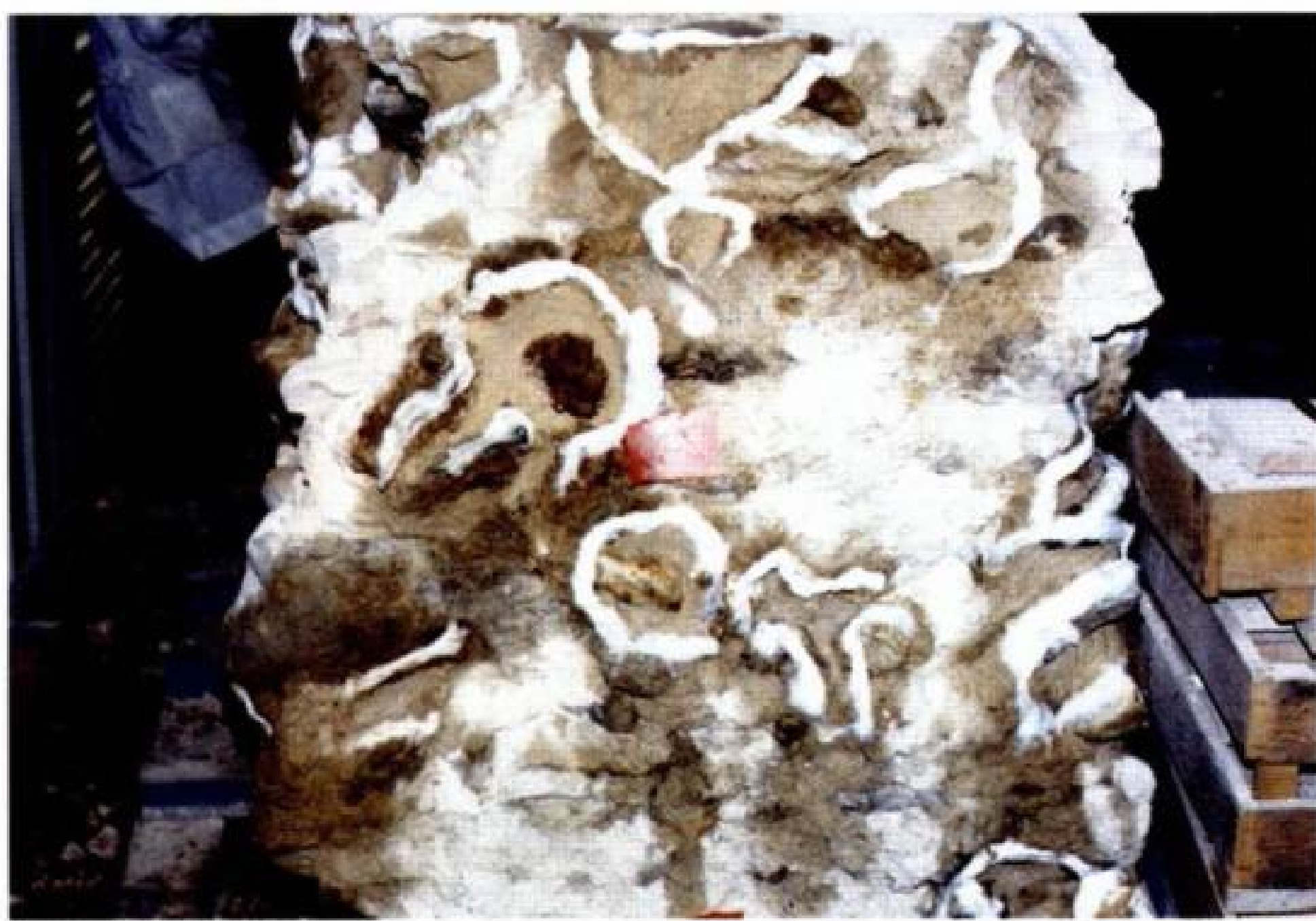
Διαδικασία στερέωσης της λιθοδομής του βαλανείου
