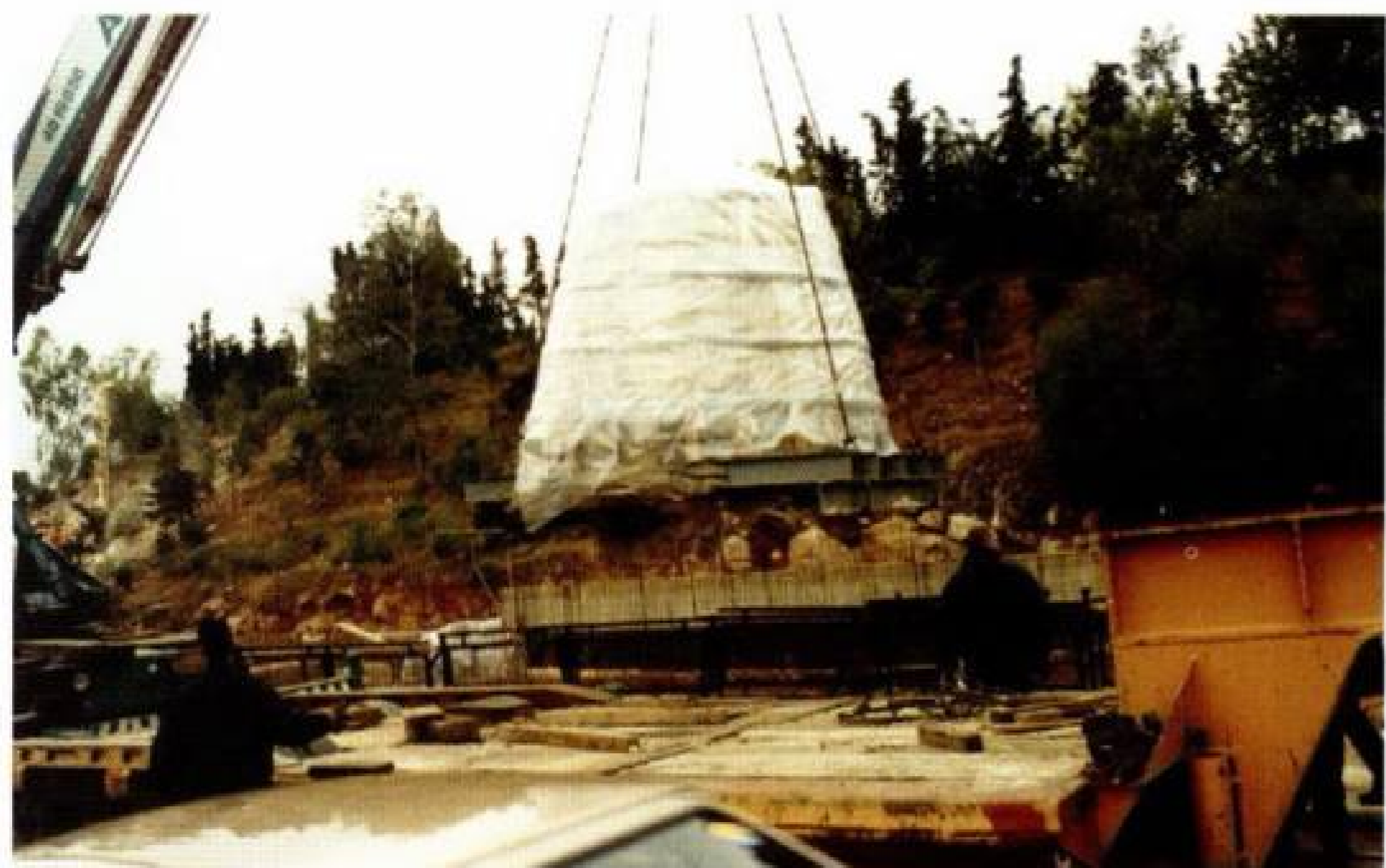
Διαδικασία μεταφοράς και τοποθέτησης του συρού.
