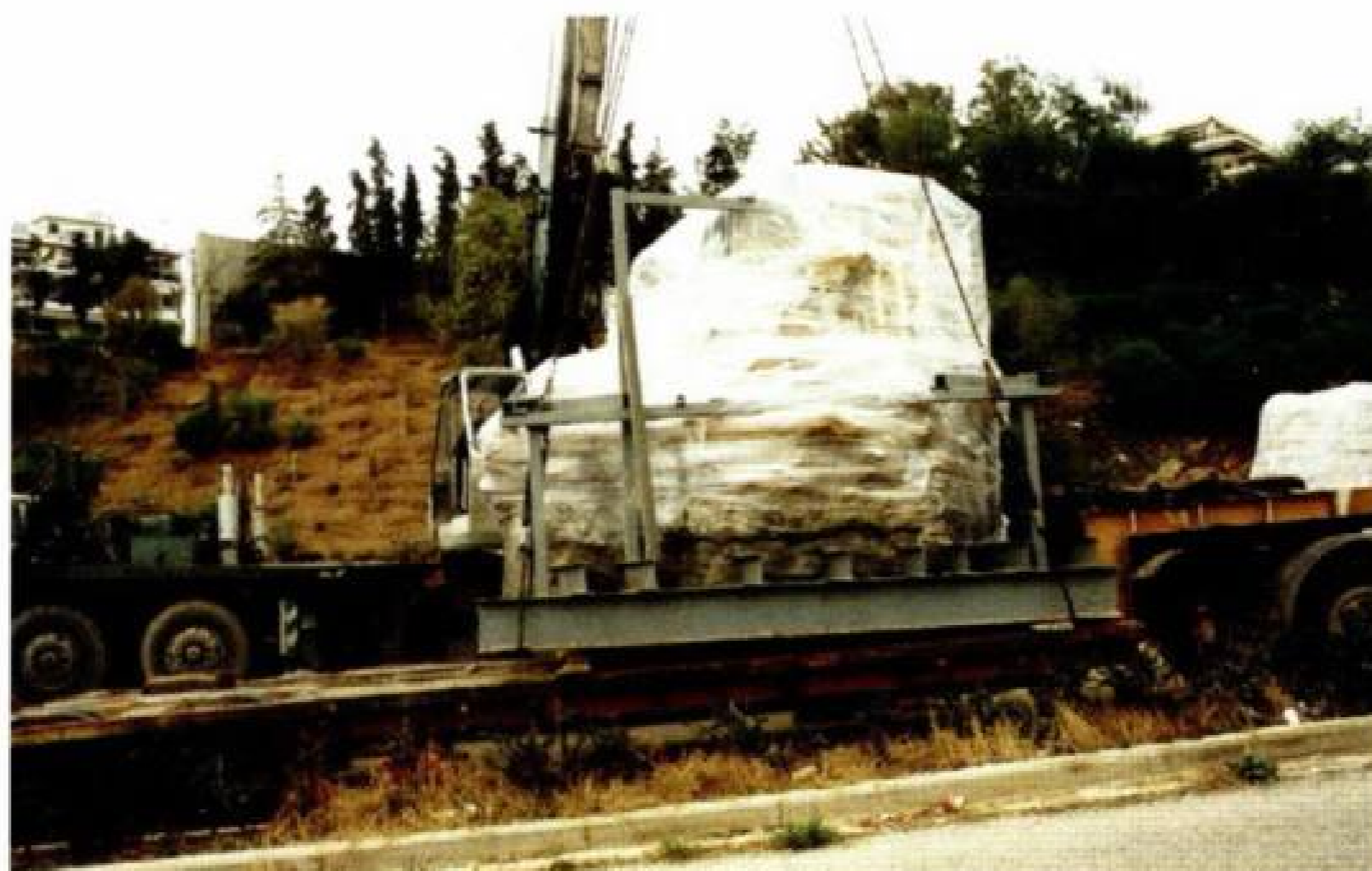
Διαδικασία μεταφοράς και τοποθέτησης τμήματος του υδραγωγείου.
