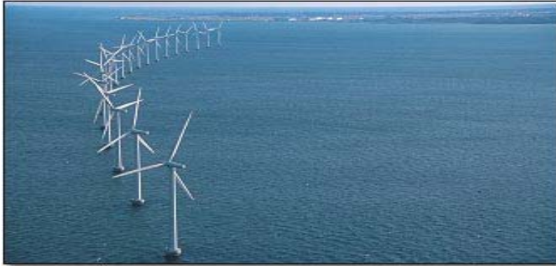
ΕΙΚΟΝΑ 2.1 Το αιολικό πάρκο Middelgrunden, που ολοκληρώθηκε το 2001, βρίσκεται στη θάλασσα ακριβώς απέναντι από το λιμάνι της Κοπεγχάγης στη Δανία.
